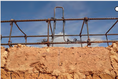
CADENA DE CERRAMIENTO Soporta tensiones de la corona del muro y permite anclar la techumbre contra fuertes vientos
