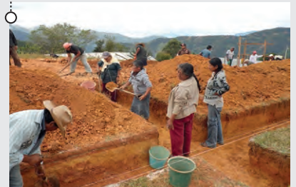
EXCAVACIÓN Se delimita el área a construir marcando la sepa de cimentación con cal
