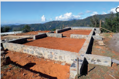
CIMIENTO Y RODAPIE El cimiento da soporte a la casa y el rodapie protege los muros del desgaste y humedad
