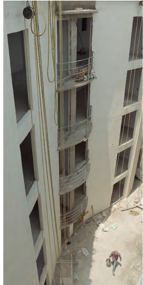
Guendaliza'a en obras. Fotografía: Jerónimo Díaz.
