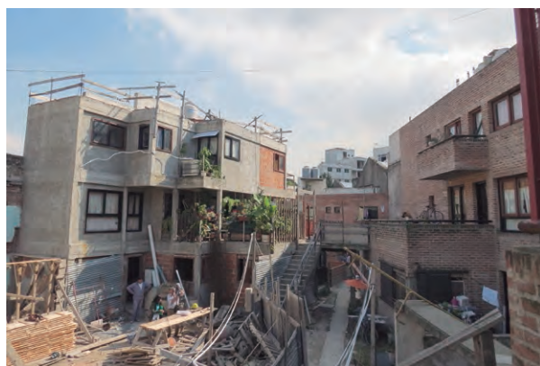
Avance de obra de la cooperativa Yatay. Fotografía: Pierre Arnold.
