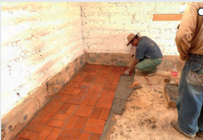
FIRME Y PETATILLO Se coloca el firme de concreto sobre suelo aplanado y nivelado. Acabado de petatillo con junta y cuatrapeo
