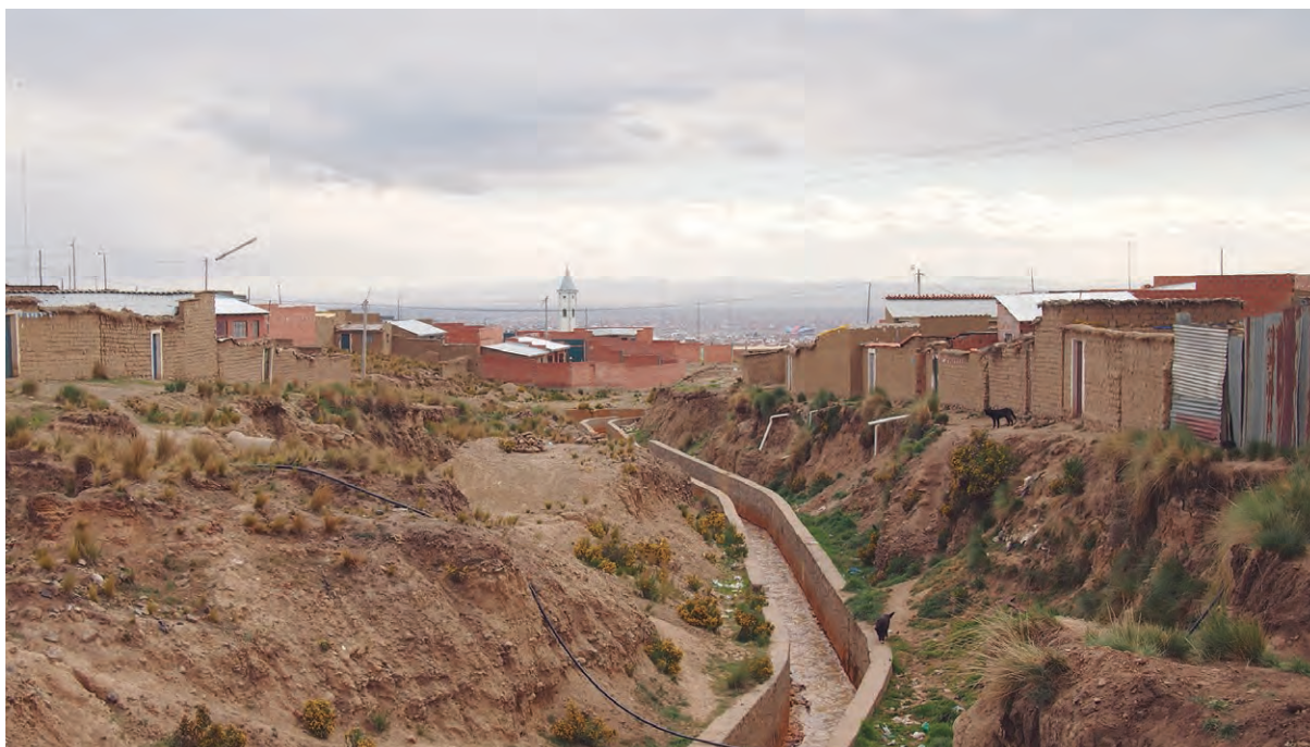
El colector principal del barrio Solidaridad, producto de la lucha de CISACA. Fotografía: Pierre Arnold.
