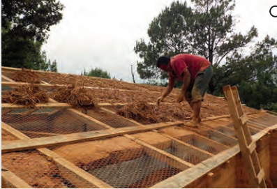
AISLANTE DE PAJARCILLA Mejora la capacidad térmica de la vivienda
