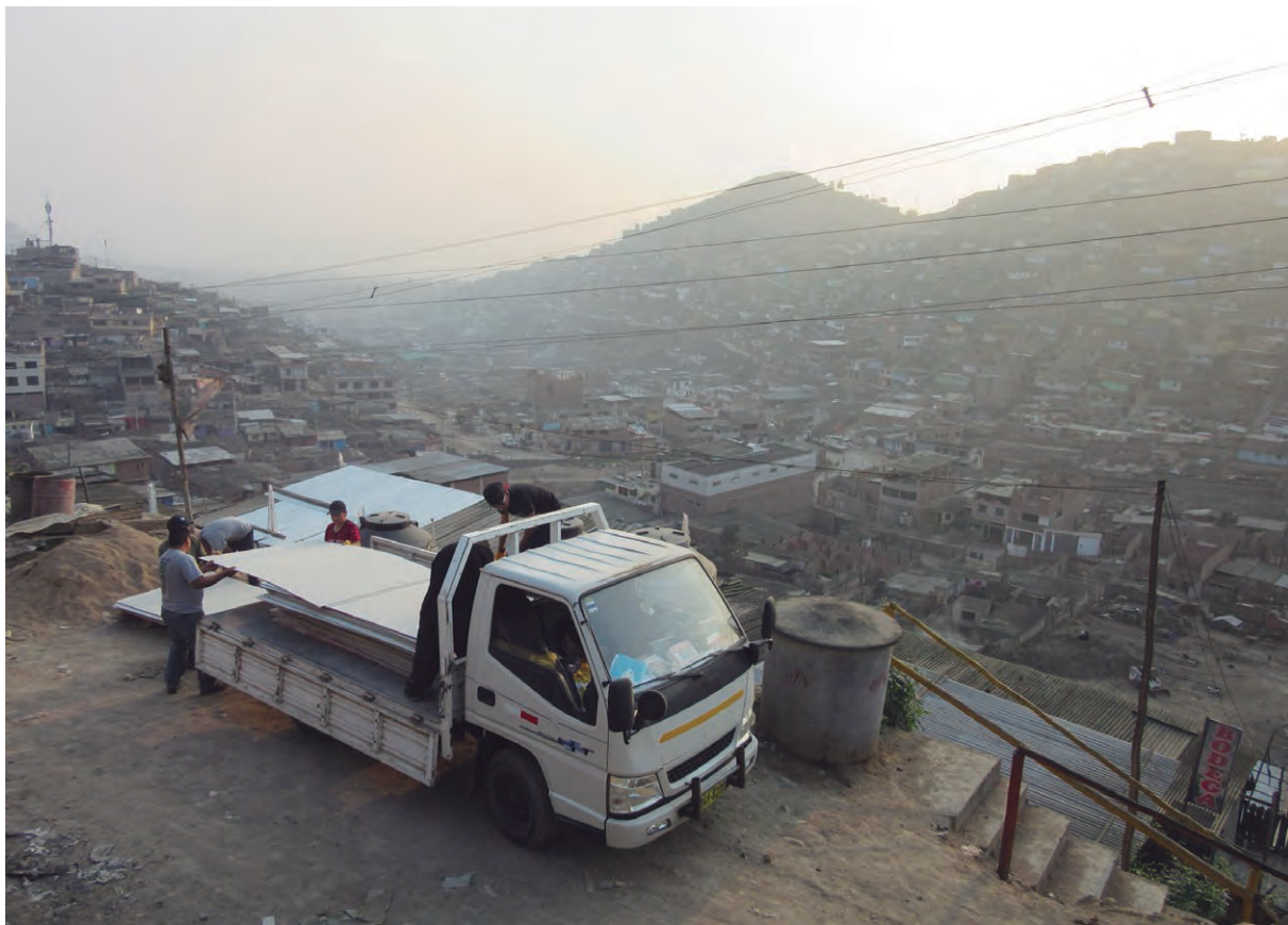
Arribo de paneles de tablaroca para la construcción de un módulo de emergencia. Fotografía: Desco.
