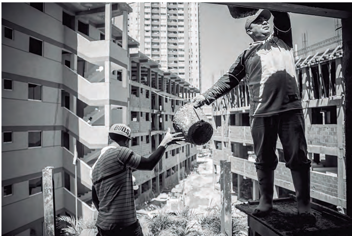
Construcción por ayuda mutua en el campamento Kaika Shi. Fotografía: Darwin Dikó Cañas Betancourt.
